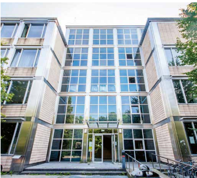
Eingang zum Gebäude des Fachgebiets Lichttechnik der TU Berlin © TU Berlin
