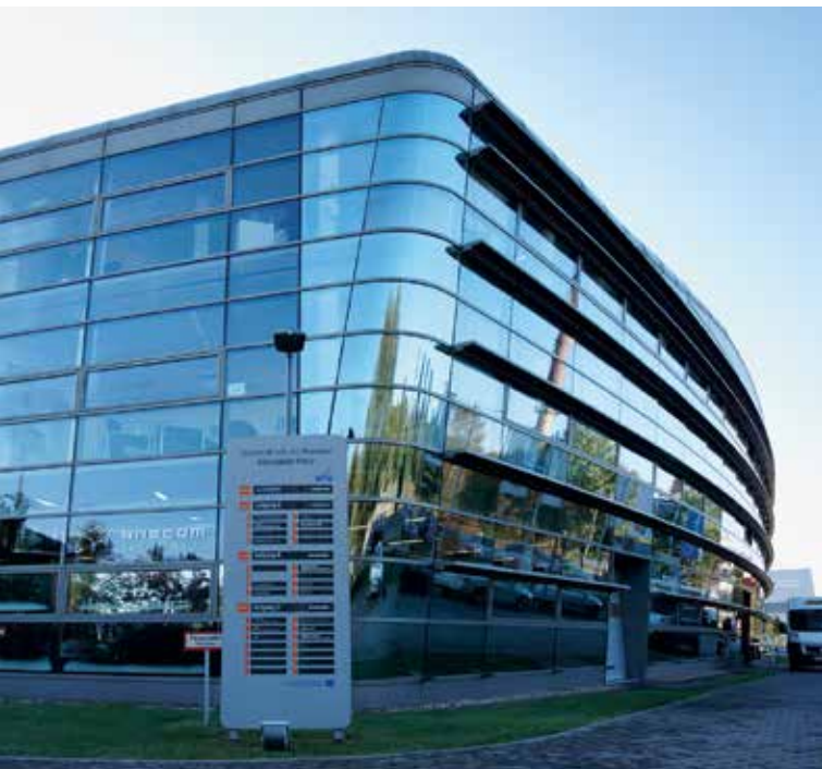
Außenansicht des Wildauer Zentrums für Luft- und Raumfahrt © Wirtschaftsförderung Land Brandenburg GmbH, Fotograf: Ulf Boettcher
