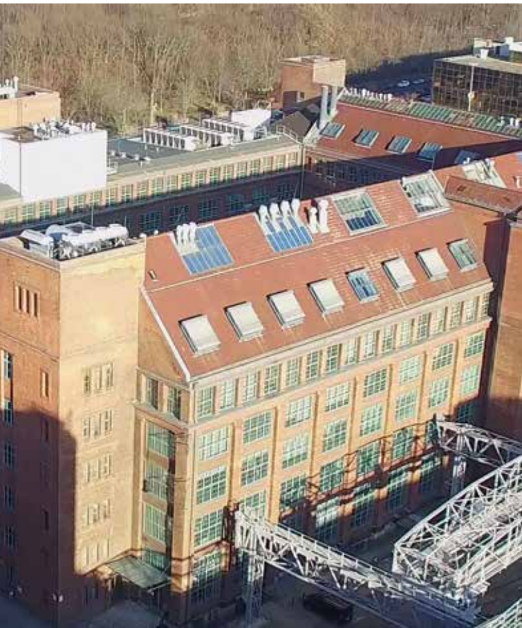
In den denkmalgeschützten Gebäuden des alten AEG-Geländes wird heute an der Technik für das Internet von morgen gearbeitet © Janine Wald/dmp-agentur
