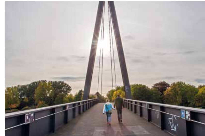
Der Kaisersteg in Schöneeweide verbindet als Fußgängerbrücke Nieder- und Oberschöneeweide
